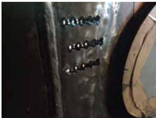
補強材(LOCK)施工
