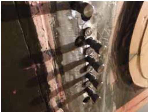
特殊ピン施工状況
