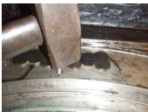
クラック進展防止に大きな補強材 (LOCK60)を施工
