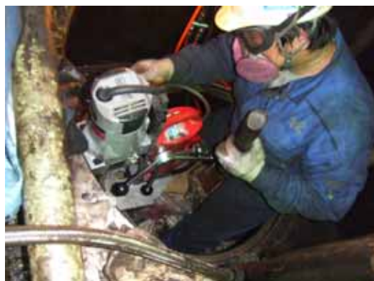
シリンダー内部での作業
