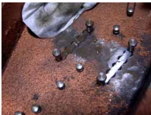
補強材(LOCK15)施工作業
