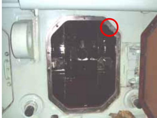
クランクケース点検扉のボルト穴を修理
