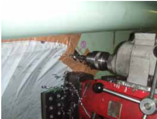
ドリル作業及びヘリサートの除去
