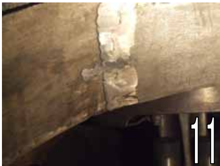
LOCK 施工状況
