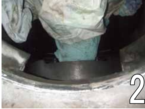
破損部分破断面加工
