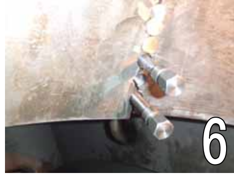
スティッチング状況
