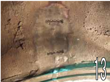
LOCKドリル工程完了
