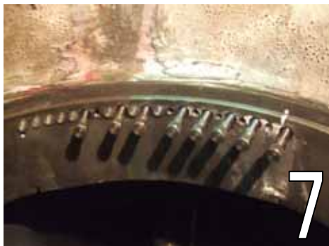
スティッチング状況
