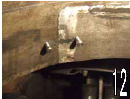
LOCK 固定ピン施工
