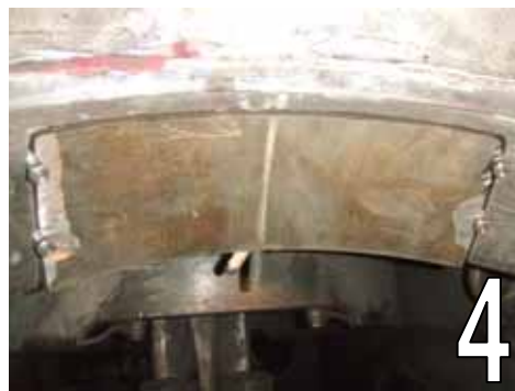
パッチ仮止め状況
