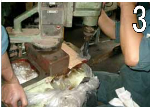
インサート施工(ドリル工程)
