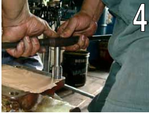
インサート施工(タップ作業)
