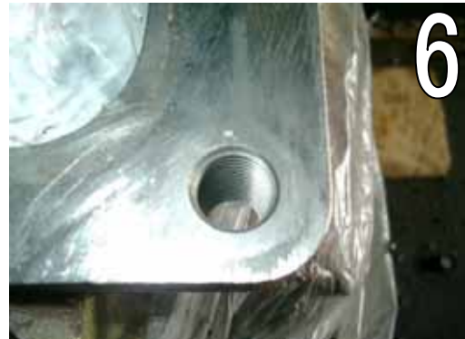
インサート施工完了
