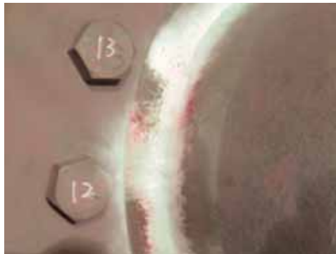
最終仕上げ後、浸透探傷検査(PT)
