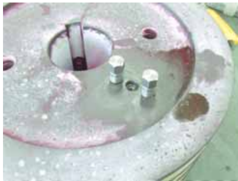
亀裂に対して特殊ピンを設置
