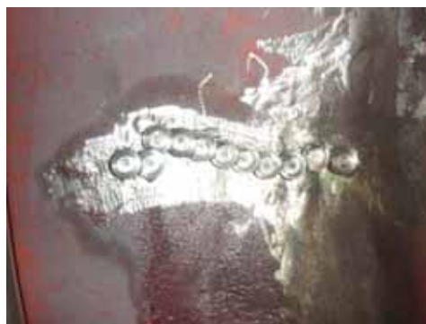
特殊ピンを重ねて設置し亀裂を除去
