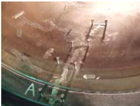
補強材挿入作業
