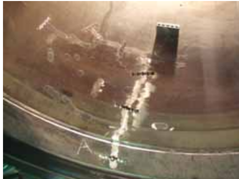
補強材の穴あけ作業
