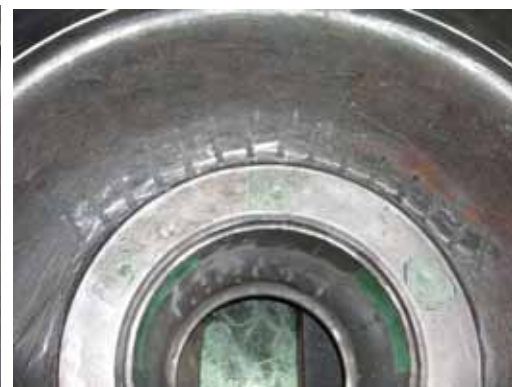
補強材(LOCK)施工完了
