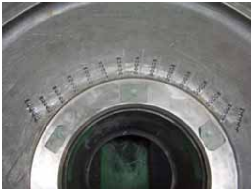
補強材(LOCK)施工用穴加工作業
