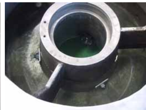
ケーシング内面より水張り試験実施
