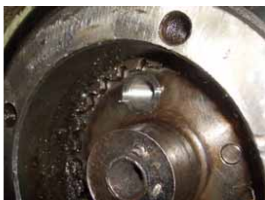
スリーブ施工後、周り止めピン施工
