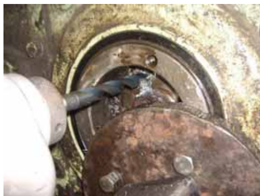
オーバーサイズでドリル加工 タップ加工 ネジ穴補修スリーブ施工
