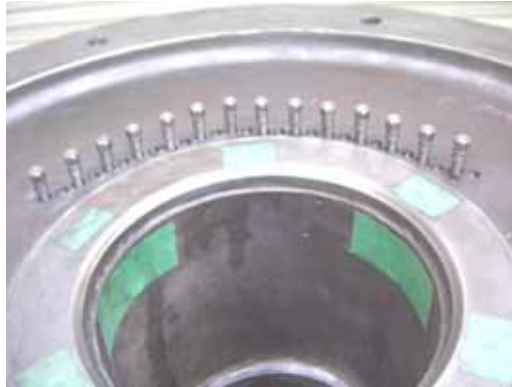
特殊ピン施工
