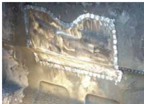
『パッチ』施工状況
