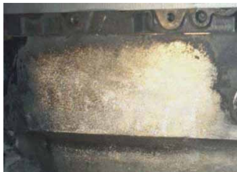
施工後の表面仕上
