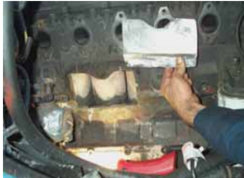
『パッチ』製作状況
