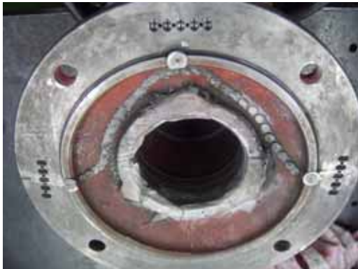
フランジ部に補強材(LOCK)施工
