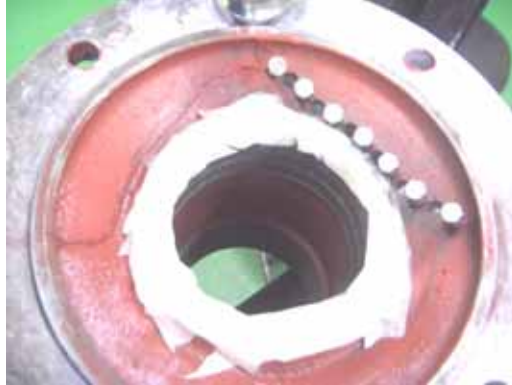
内面より特殊ピンを施工
