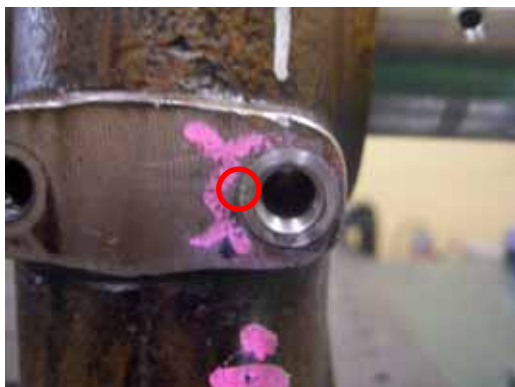
インサート及び周り止めピン施工完了
