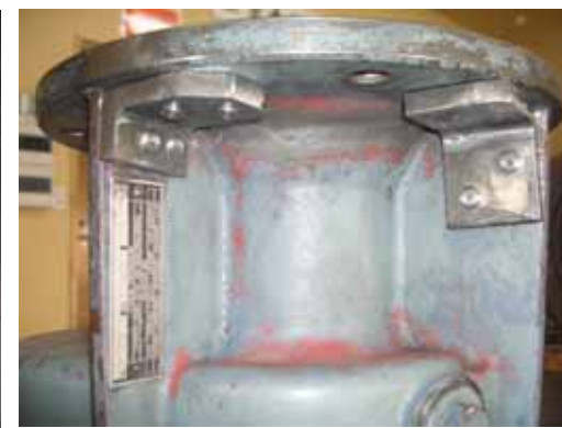
外面にプレートを設置し、リブ補強実施
