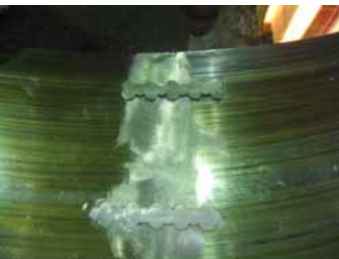
LOCK施工状況
