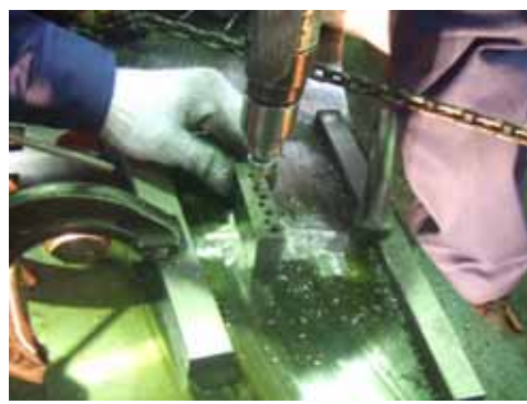
LOCK施工の為のドリル作業
