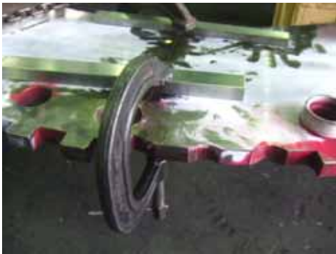
円盤状のプレートの亀裂部の固定状況
