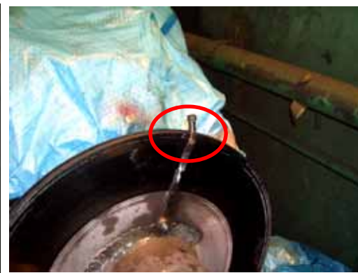
特殊ピンを斜めに設置し、角部を修理
