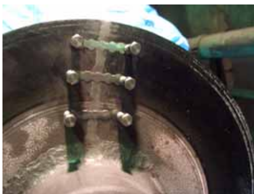
補強材(LOCK)設置
