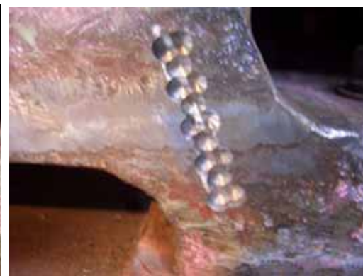
LNS LOCK 施工の為のドリル加工
