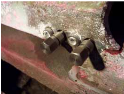
特殊ネジ施工状況
