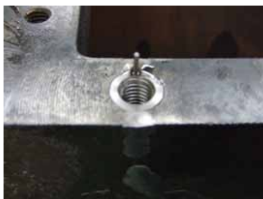
スリーブ設置後、周り止めピン施工
