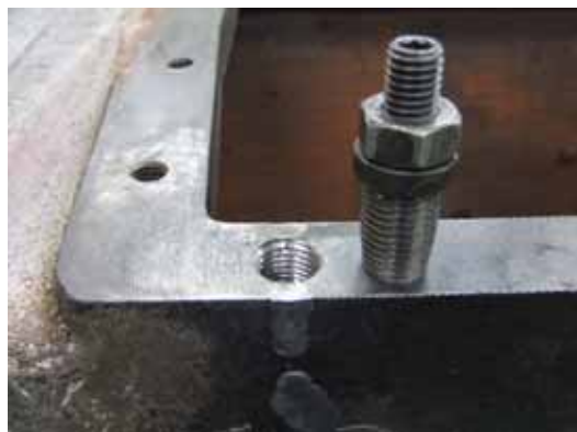
ボルト穴への穴加工を行い、特殊スリーブ (インサート)を施工
