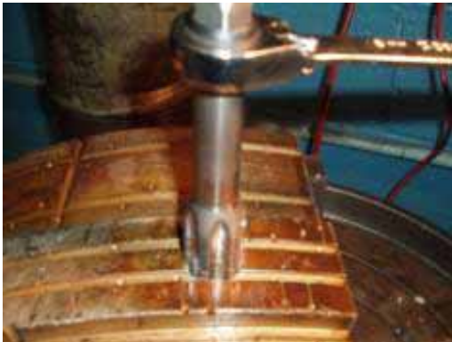
弊社スリーブ施工の為のタップ作業
