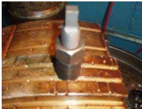
弊社特殊スリーブ施工
