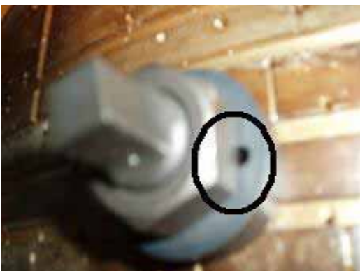
母材との境界面に周り止めピンを施工
