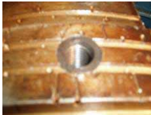
特殊スリーブ(Full-Torque)施工完了
