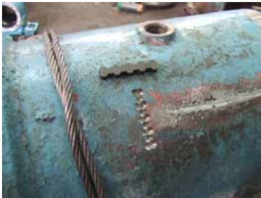
補強材設置用の穴加工作業
