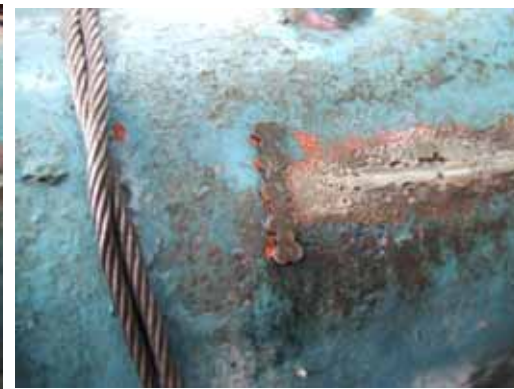
補強材設置作業（進展方向端部）
