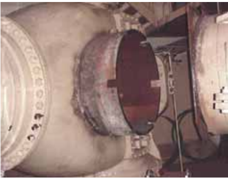
配管側加工状況
