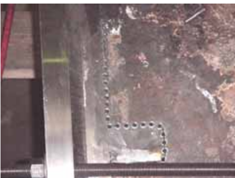
スティッチングドリル工程
