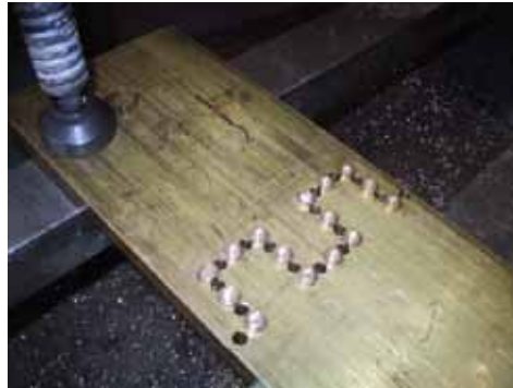
銅板切断部スティッチング状況
