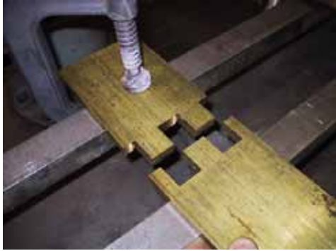
銅板切断状況
