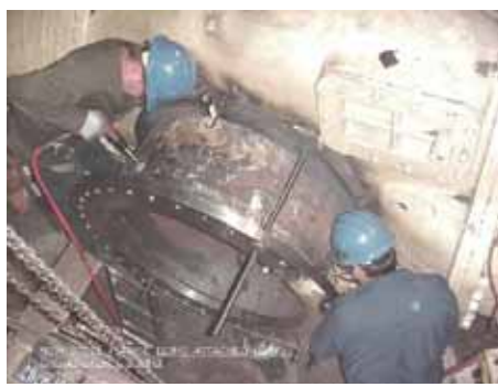
施工作业状況
