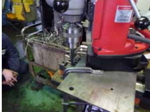
弊社スリーブ施工の為の穴加工作業
