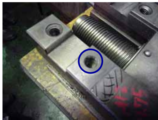
特殊スリーブ(Full-Torque)施工完了
